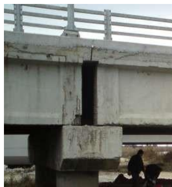
Σχήμα 7. Απολέπιση σκυροδέματος (αριστερά) και φθορά σκυροδέματος λόγω κακής απορροής υδάτων (δεξιά) – γέφυρα Στρυμόνα
