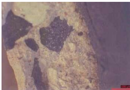
Σχήμα 6. Μικροσκοπική παρατήρηση σκυροδέματος πυρήνων – γέφυρα Αξιού
