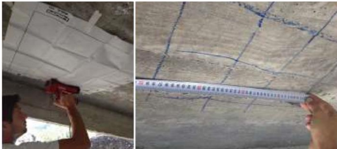
Σχήμα 2. Ανίχνευση και χαρτογράφηση οπλισμού
