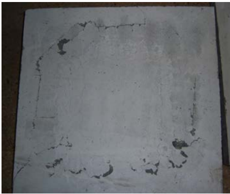
Εικόνα αστοχίας δοκιμίου Δ-A-1
